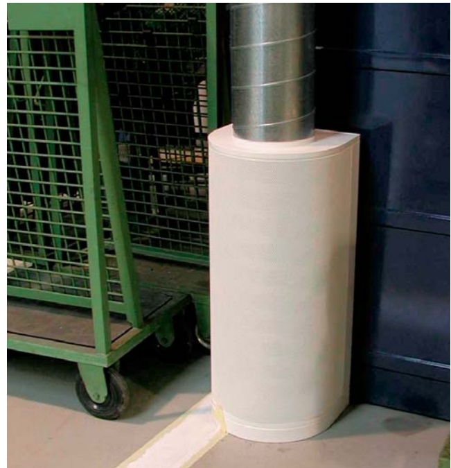
Abb. 15: Zuluft durch Quellaufdurchlass
